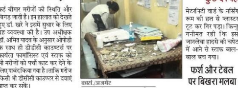
मेटरनिटी वार्ड के नर्सिंग रूम की छत गिर पड़ी। प्लास्टर गिरने से रोगी को खतरा हो सकता है। इस जगह से गिरने वाले प्लास्टर के टुकड़ों में से कई का नर्सिंग रूम में गिरा जा चुका है।
